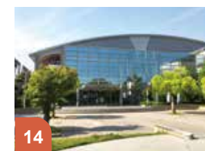
14 西尾市総合体育館 ボクシング
